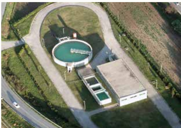
Potabilizzatore di Torno
