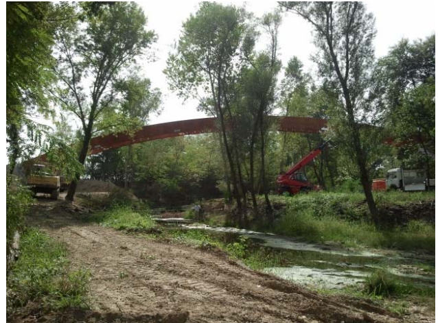
Attraversamento fiume Nevola con Ponte in legno ad unica campata 60m
