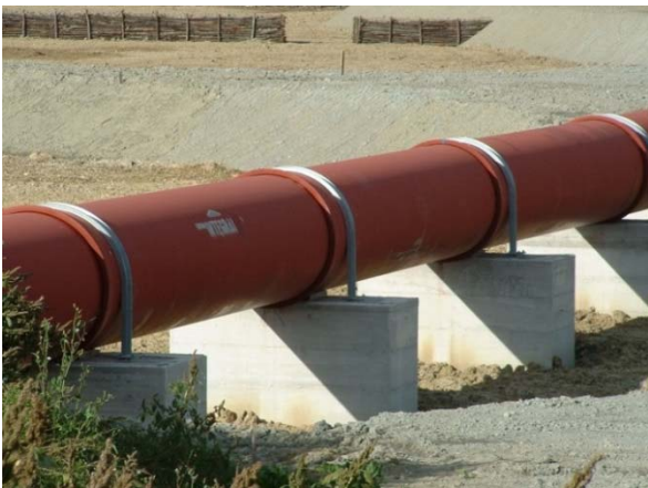
Collettore in ghisa sferoidale DN 1500
