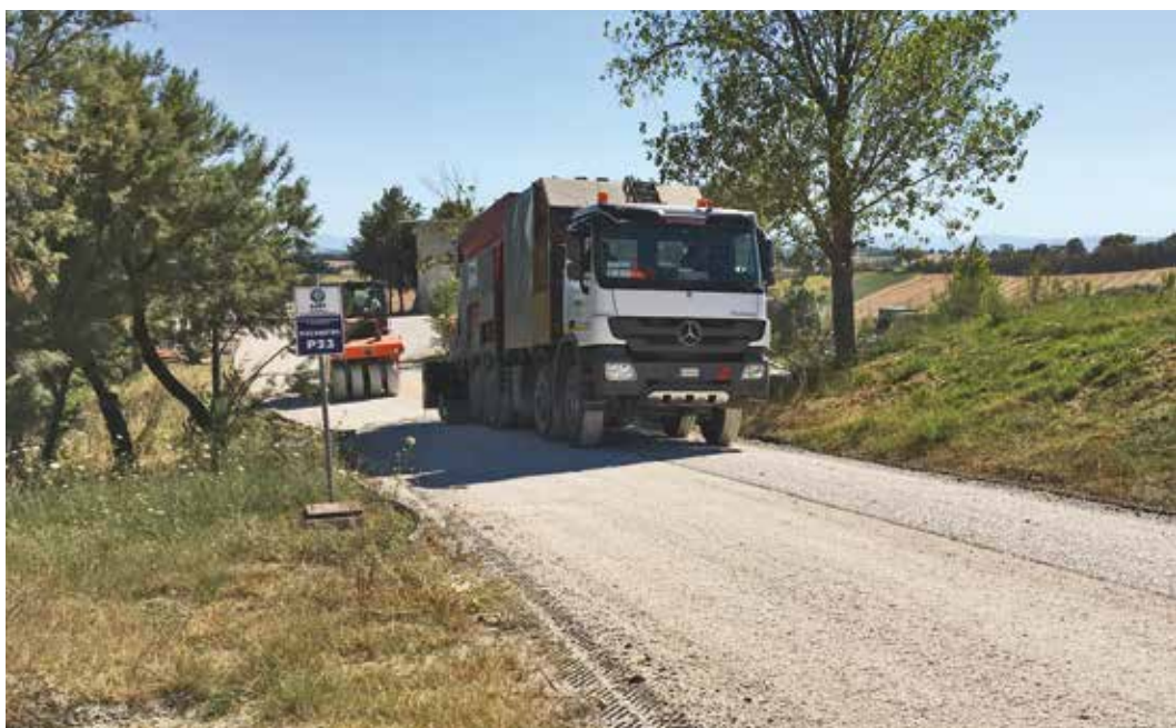
12. L'applicazione del trattamento di depolverizzazione e la successiva rullatura
