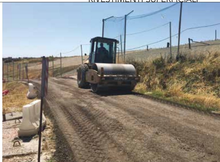
11. La compattazione del misto cementato con fresato con rullo ferro-gomma
